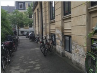
Underfacade mod gaden, pudsede
